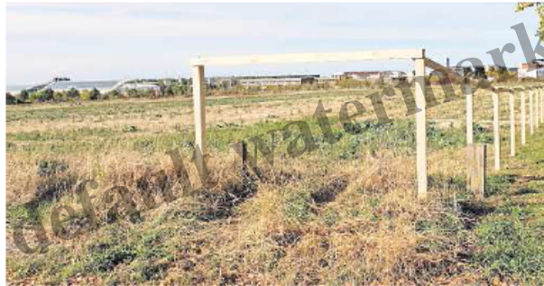
Die Erschließung des Neubaugebiets Kronsberg-Süd hat vor einigen Monaten begonnen.
